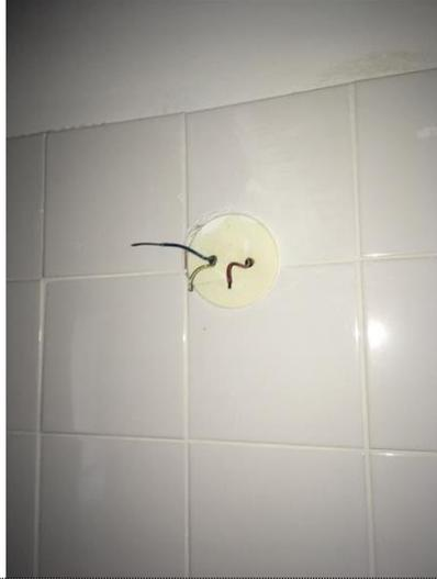
**Description :** Local contenant une baignoire ou une douche : l'installation électrique ne répond pas aux prescriptions particulières appliquées à ce local (adéquation entre l'emplacement où est installé le MATERIEL ELECTRIQUE et les caractéristiques de ce dernier – respect des règles de protection contre les chocs électriques liées aux zones).
